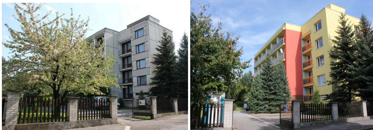
Obrázek 6: DPS v ul. Sadová 2755 před a po první fázi rekonstrukce
